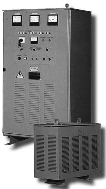
Возбудители тиристорные типа ВТЕ-315-6М предназначены для питания обмотки возбуждения и управления током возбуждения при прямом и реакторном пуске, синхронной работе и аварийных режимах синхронных электродвигателей.
